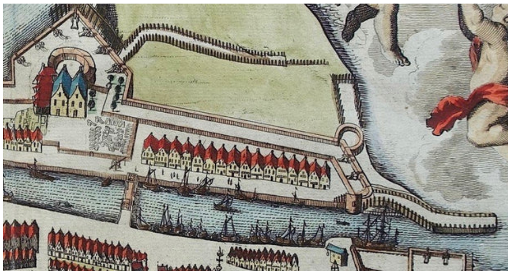
Noordzijde van de Veerse haven, Smallegange 1696
